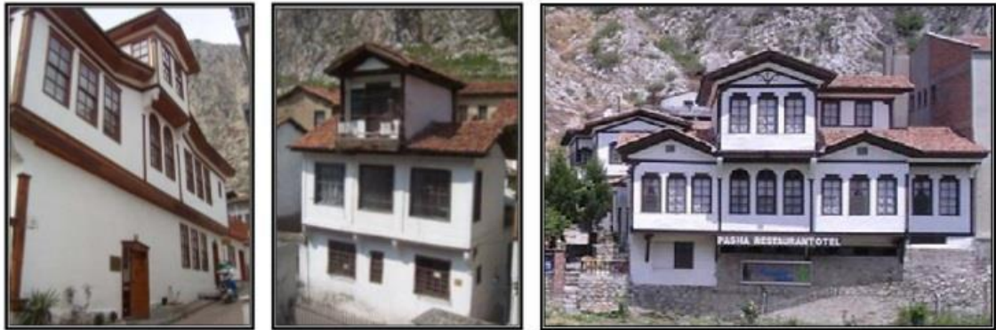
Şekil 8: Yalıbozu Evleri'nde 'şahnışın' örnekleri
